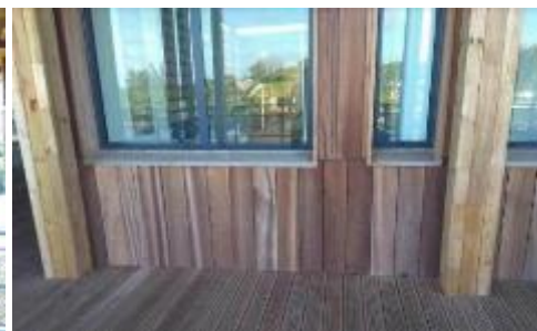
Boiseries avec usure prématurée
