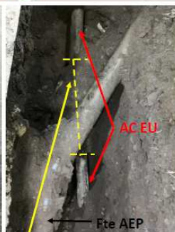
Tronçon à remplacer (env. 2,20 ml)
